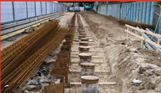
Fundering van het nieuwe spoor 1 is klaar.
