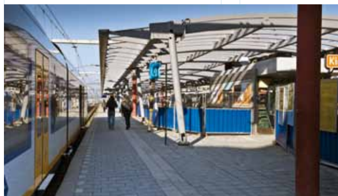
Derde perronkap in aanbouw, op half afgesloten perron
