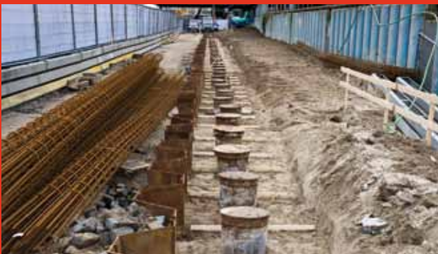
Fundering van het nieuwe spoor 1 is klaar.
