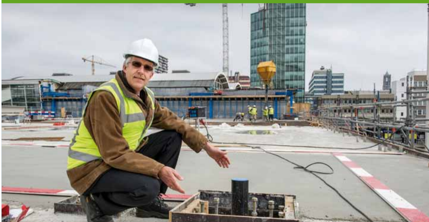
Jan Faber bij de betonnen stortingen waar de kolommen en later het dak van de nieuwe hal op komen te rusten. De blauwe palen op de achtergrond vormen de tijdelijke ondersteuning van het oude dak.
