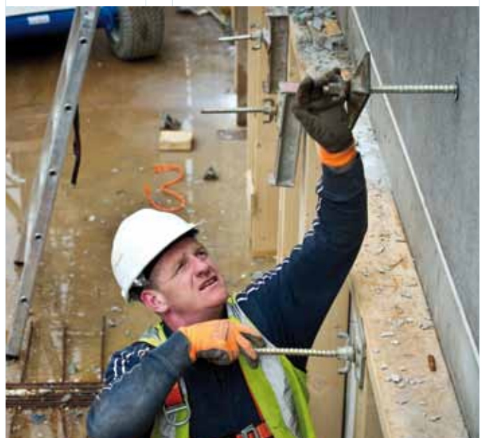
Verwijderen van speciale pennen na het storten van beton
