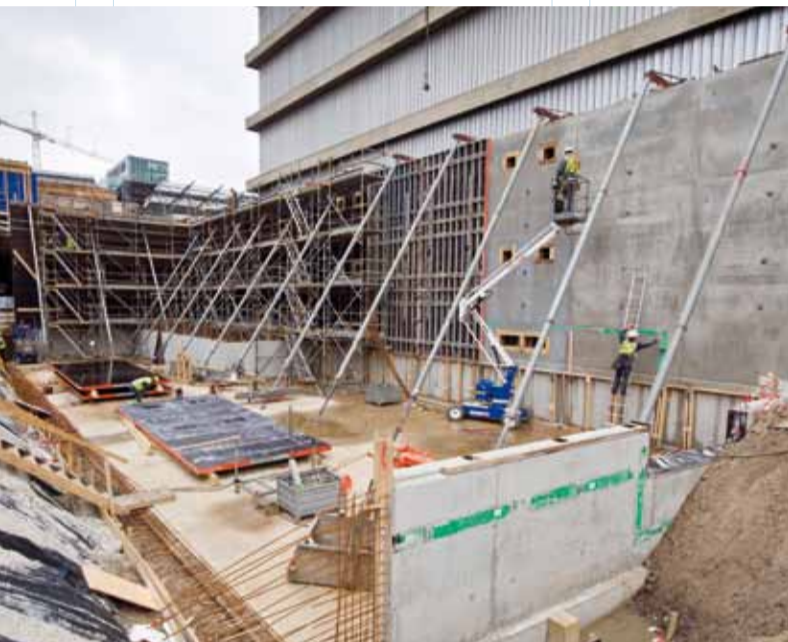
Ingang Jaarbeurskant in aanbouw, april 2012
