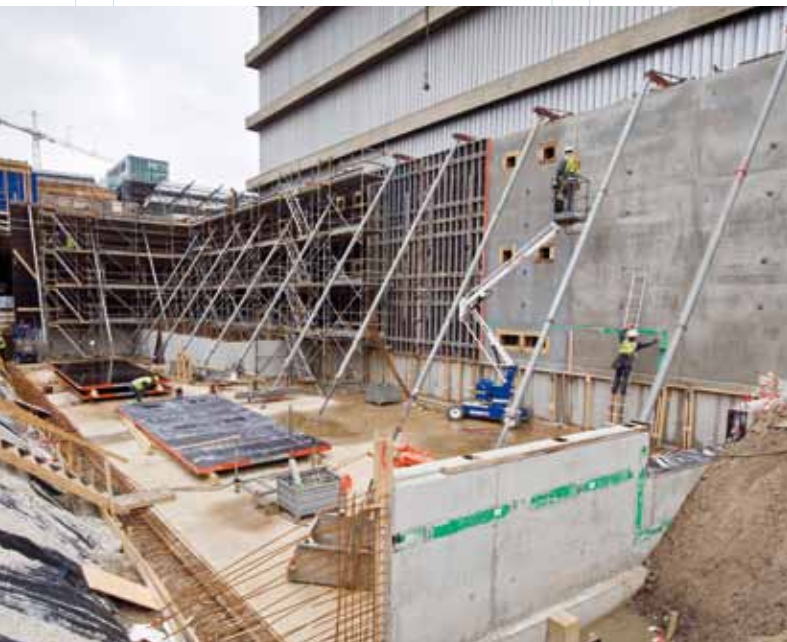
Ingang Jaarbeurskant in aanbouw, april 2012
