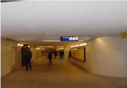
De tunnel in oude staat.
